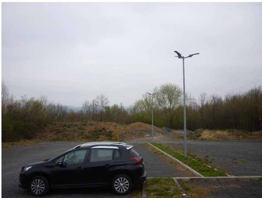
Abbildung 7: Blick Richtung Südwesten vom Parkplatz auf den zusammengeschobenen Wall.
